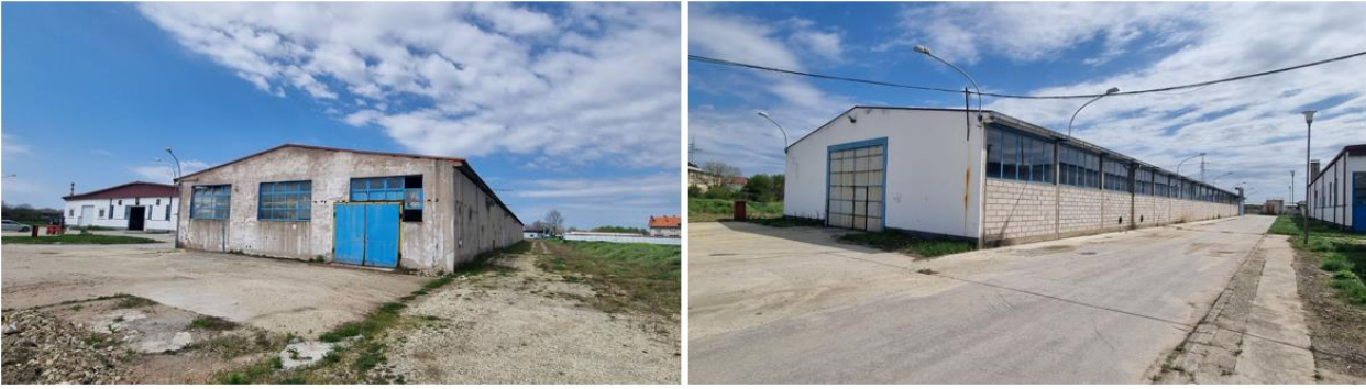
Слика бр. 4: Приказ производног објекта 1
