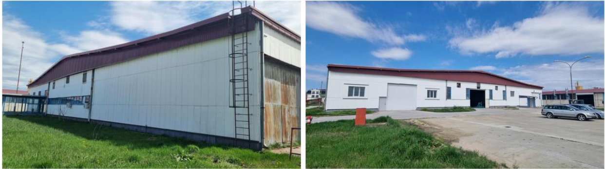
Слика бр. 5: Приказ производног објекта 2
